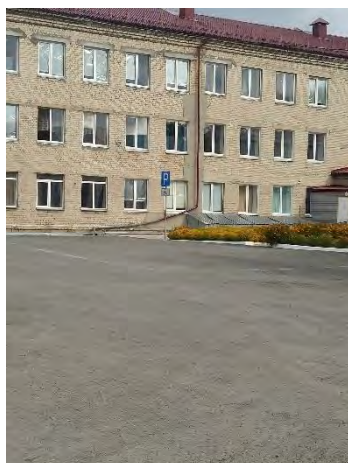
Учебный корпус 1 Вход с ул. Пушкина
